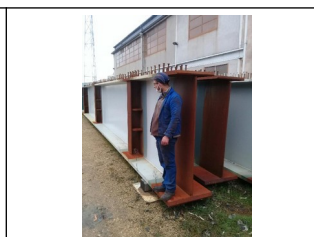
6 éléments composeront les 2 poutres de la charpente de l'ouvrage (poids environ 15 T / élément)
