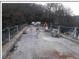
05-01-2021 Découpe du tablier au câble pour libérer la précontrainte de l'ouvrage
