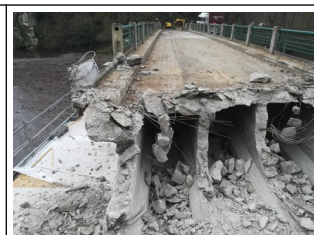
06-01-2021 Démolition de l'about de tablier côté Saint-Plantaire
