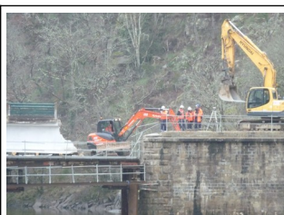
14-01-2021 Terrassement entre maçonneries conservées de la culée côté Saint-Plantaire
