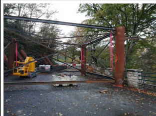
03-11-2020 Assemblage d'une palée d'étaie avant mise en place sur barge
