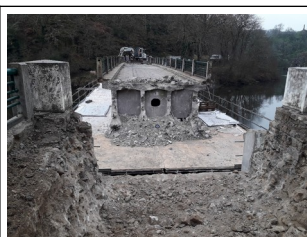
14-01-2021 Décaissement de la culée pour réalisation des nouveaux appuis de l'ouvrage en béton armé
