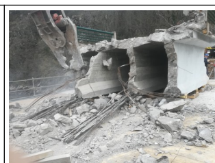
20-01-2021 Fin de la démolition du tablier
