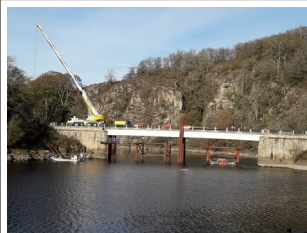
24-11-2020 Mise en place de la palée avec la barge sous l'ouvrage avant battage des pieux servant d'appuis en rivière
