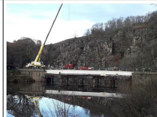
15-12-2020 Étaie et platelage en place sous l'ouvrage
