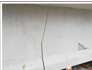
05-01-2021 Découpe au câble des poutres béton
