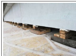
17-12-2020 Mise en place des calages tout les 1,50 m des 4 poutres béton du tablier sur le platelage de l'étaie
