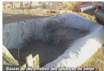
Bassin de décantation des laitances de béton
