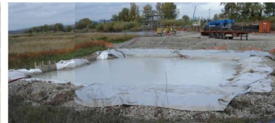
Bassin de décantation des laitances de béton
