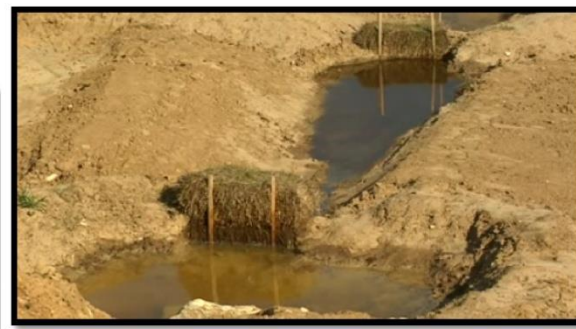
Filtre à paille et bassin de décantation
